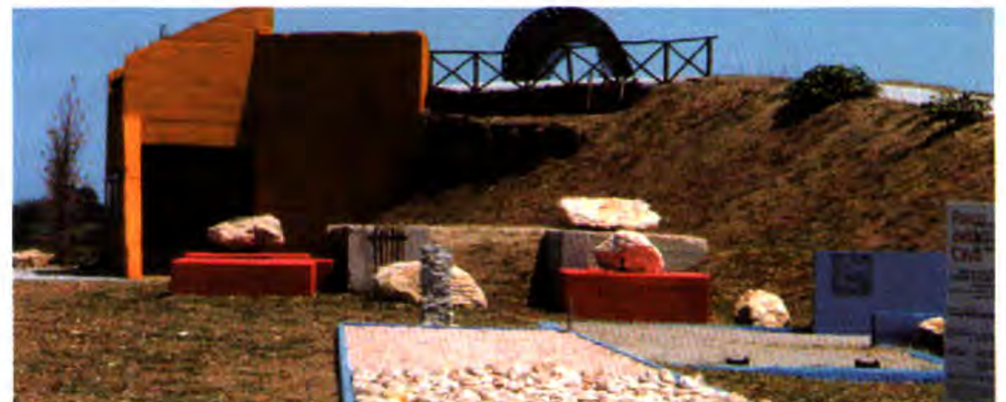
Foto 2 - La rampa belvedere modificata con l'intervento progettuale
