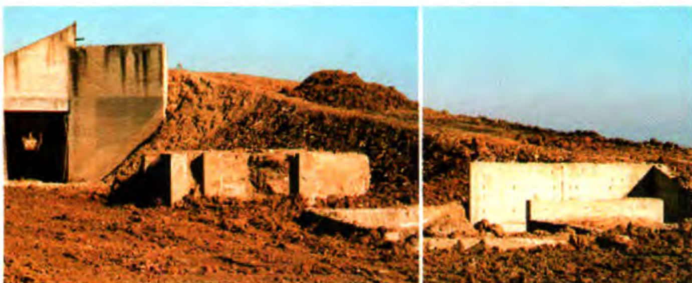
Foto 1 - La rampa dei camion e i manufatti in c.a. dopo la dismissione dell'impianto
