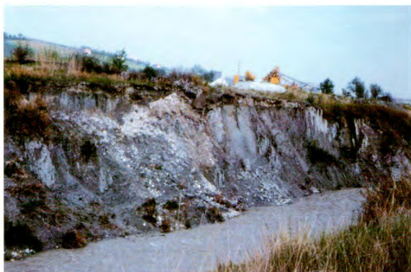
Foto 4 - Alveo canalizzato del fiume Marecchia in prossimità del Parco della Cava
